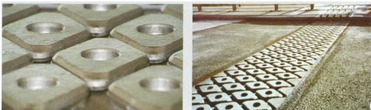
Рис. 1. Накладки, снижающие шумовую эмиссию модульного ДШ
